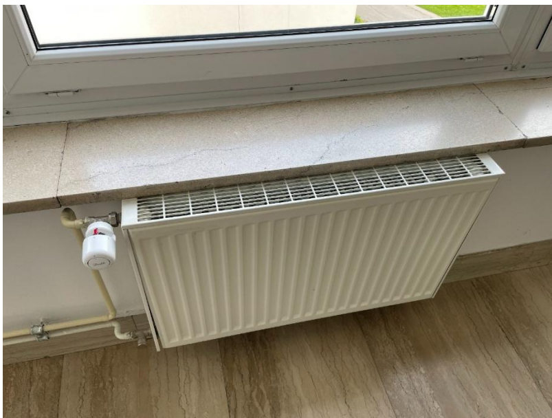
Slika 16: Panelno grelni telo z nameščenim termostatskim ventilom
