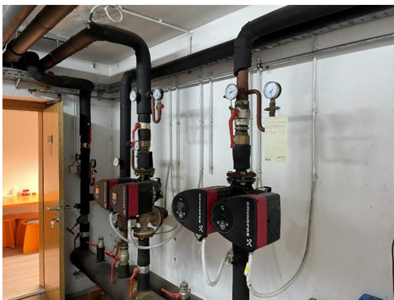
Slika 13: Toplotna podpostaja
