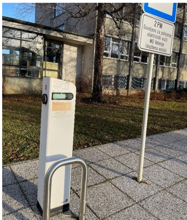
Slika 26: Električna polnilnica za polnjenje službenih električnih avtomobilov
