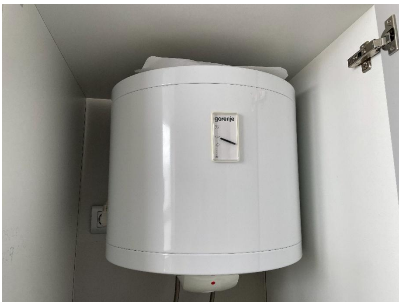
Slika 25: Električni grelnik za pripravo TSV
