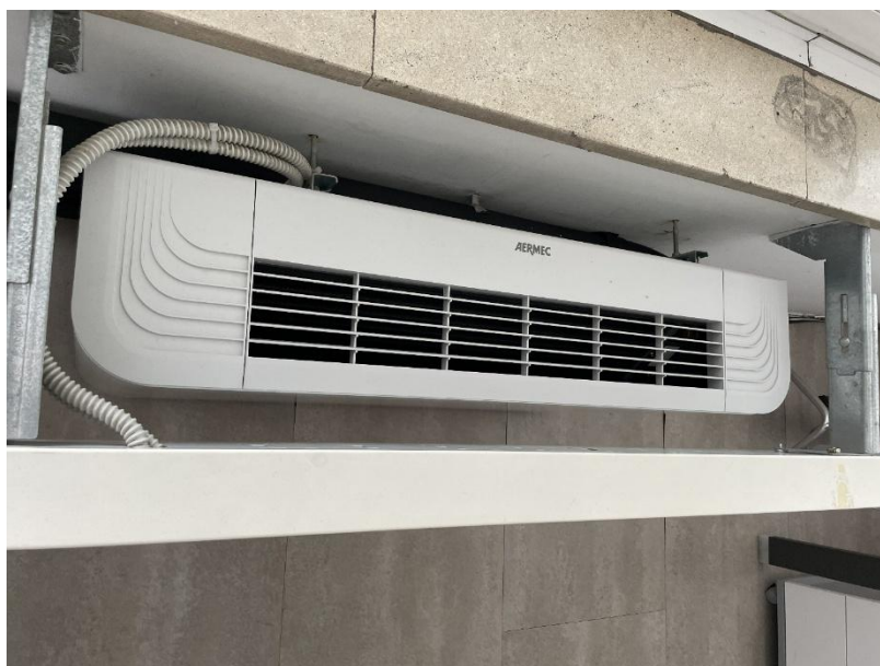
Slika 15: Konvektor toplote in hladu
