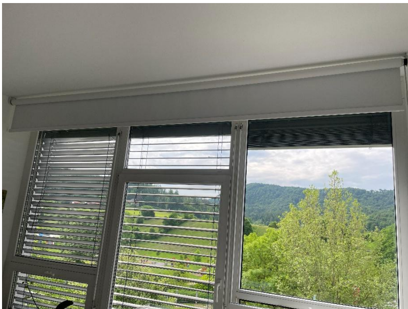
Slika 19: Zasteklitev z zunanji senčili v pisarni
